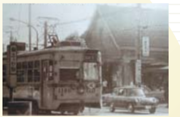
昭和40年代の保土ヶ谷駅東口前通り
